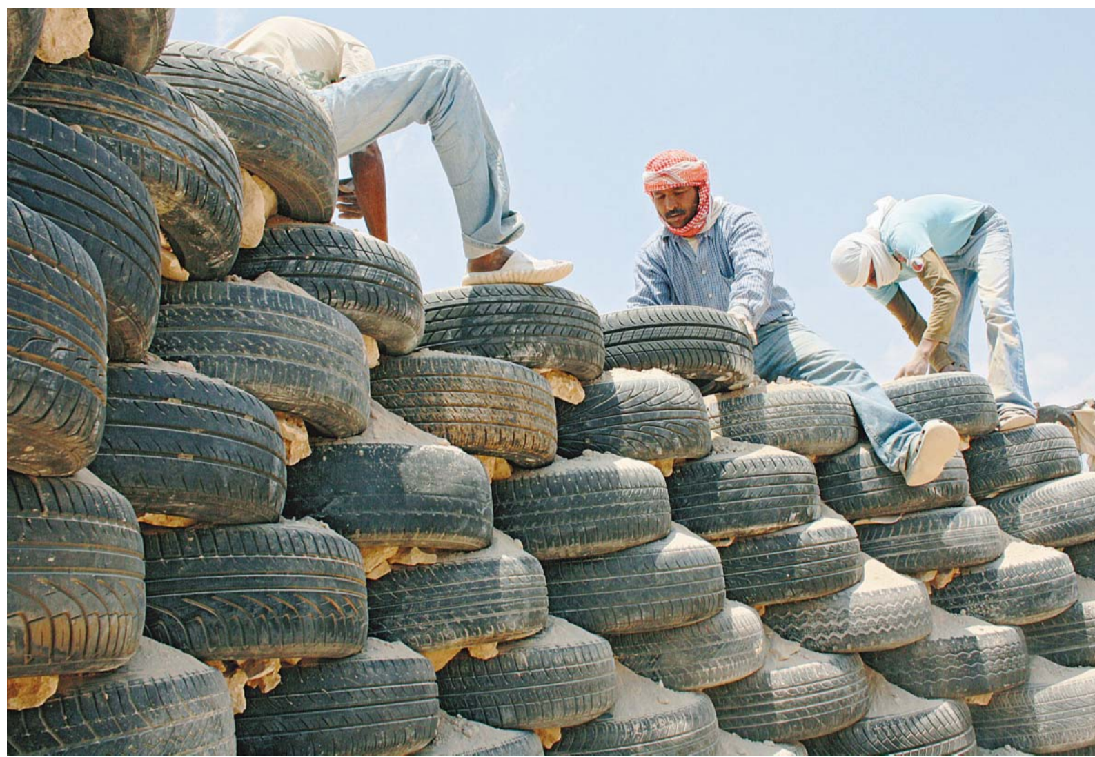
Alle haben mit angepackt: Für die Beduinen war der Schulbau eine Chance, ihre Situation aus eigener Kraft zu verbessern.
